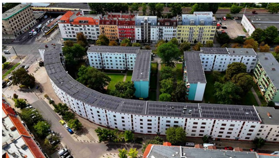
Abbildung: Photovoltaik-Anlagen; Copyright: MBG energy GmbH
